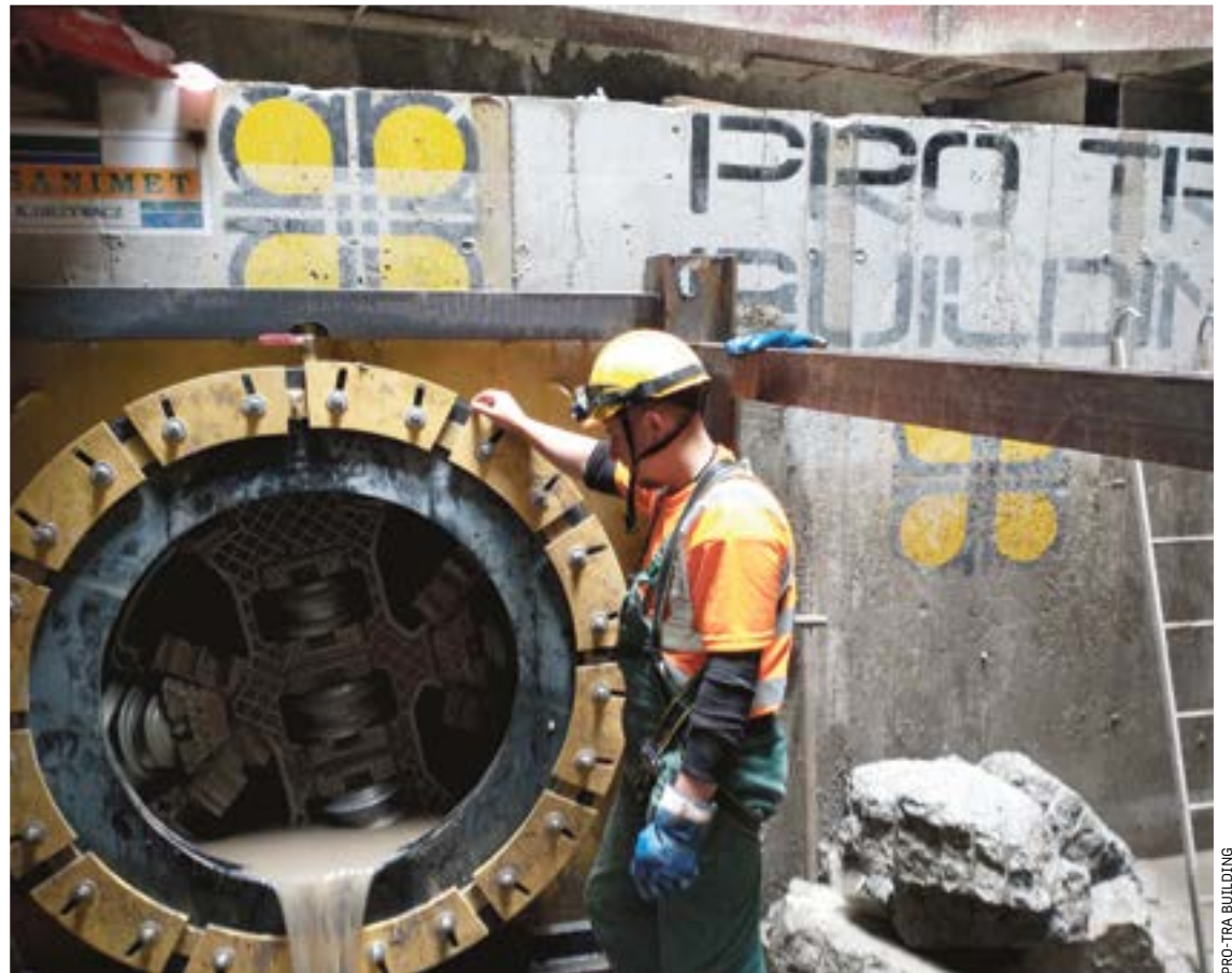
Pod dnem Odry wykonano pierwszy przewiert. Prace prowadzi firma Pro-Tra Building
